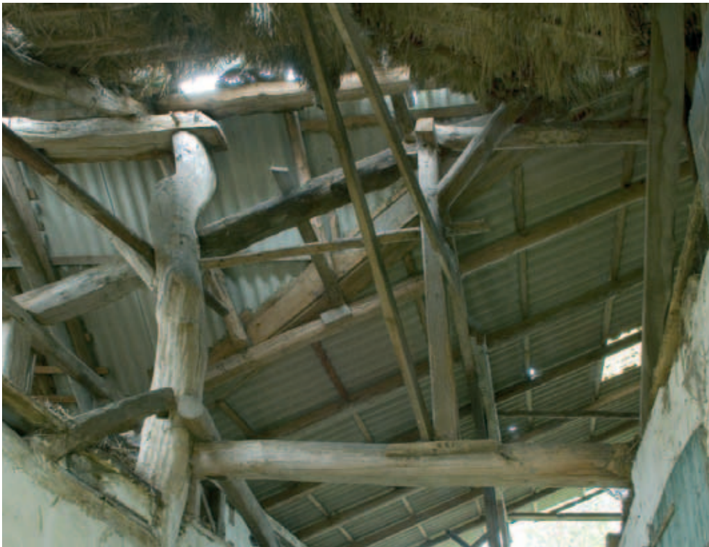
Konstruktion i sydlængens vestdel. Foto: Flemming Wedell.
