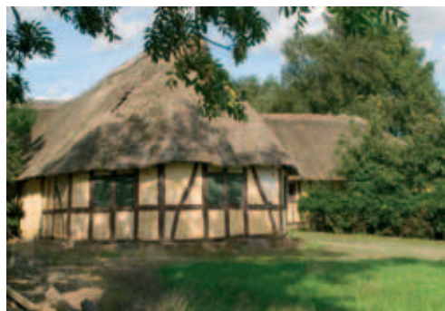
Hestegangshuset set fra sydvest. Foto: Flemming Wedell.
