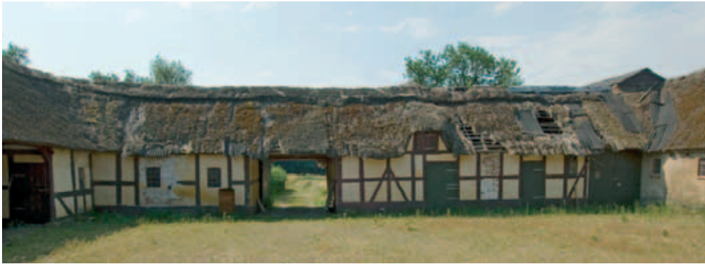
Sydlængen set fra nord. Foto: Flemming Wedell.
