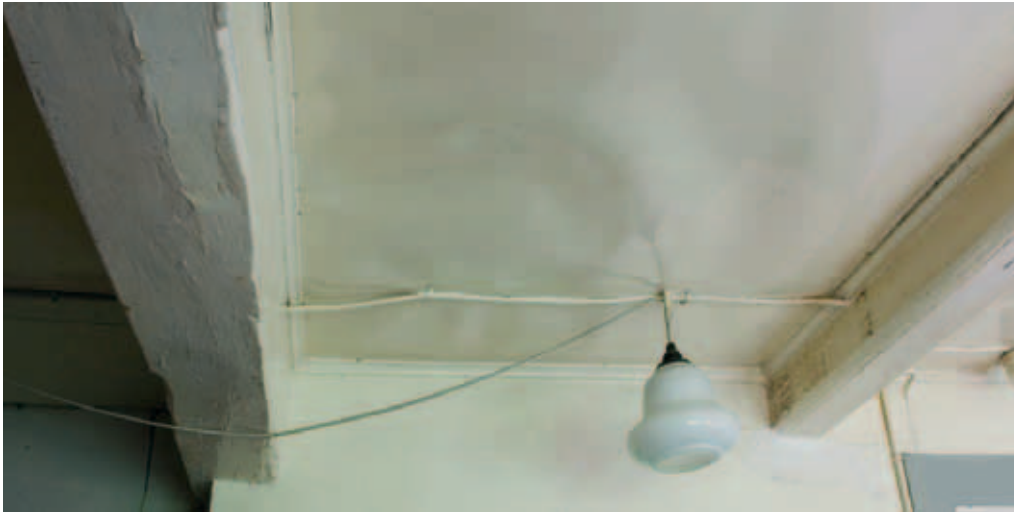
Mulig 'skorstensbærende bjælke i køkkenloftet' t.v. Foto: Flemming Wedell.
