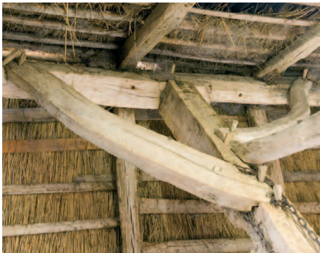
Typisk konstruktion med træ- nagler igennem og under skråbåndene. Østlængen. Foto: Flemming Wedell.
