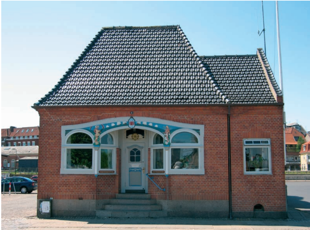
Bygningerne på og omkring havnen varierer voldsomt i udtryk og størrelse, men de er stort set alle knyttet til industrihavnenes udvikling i perioden 1840 til i dag. Her havnekontoret i Svendborg, en bygning i lilleputformat med andre små naboer som levn fra de gamle kulpladser, der lå her. De små huse har fra nutidens udviklingsperspektiv en for lav bebyggelsesprocent, men de er væsentlige brikker til den samlede havneoplevelse. Foto: Henrik Harnow, 2006.
